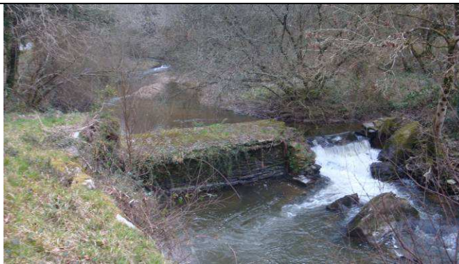
Seuil cassé au niveau du moulin de Bothoa-Bihan sur le Daoulas
